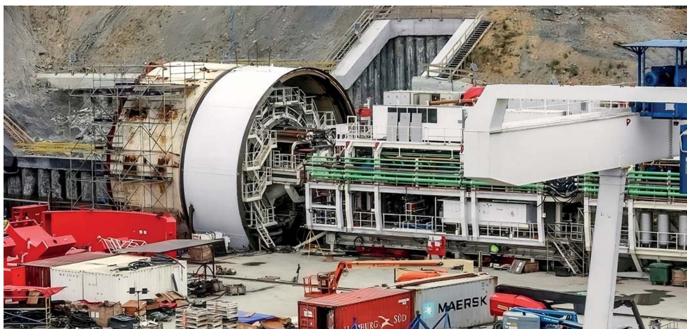
Karpatka miała zacząć drażyć tunel wiosną 2023 roku. Natrafiono jednak na metan, który opóźnił rozpoczęcie prac
