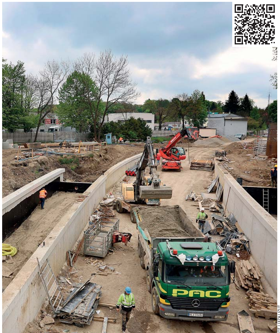
Budowa tunelu w Łańcucie idzie zgodnie z planem
